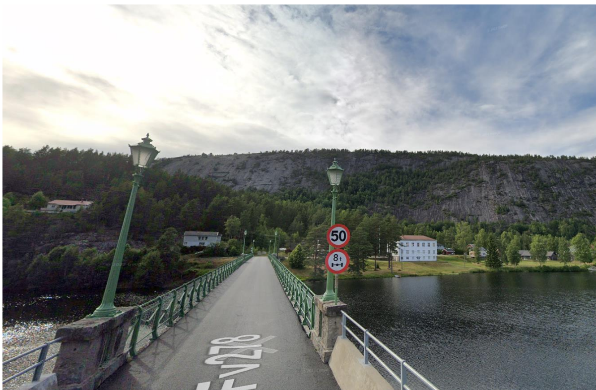
Figur 10 Åmfoss bru. Kilde: Googlemaps/streetview
