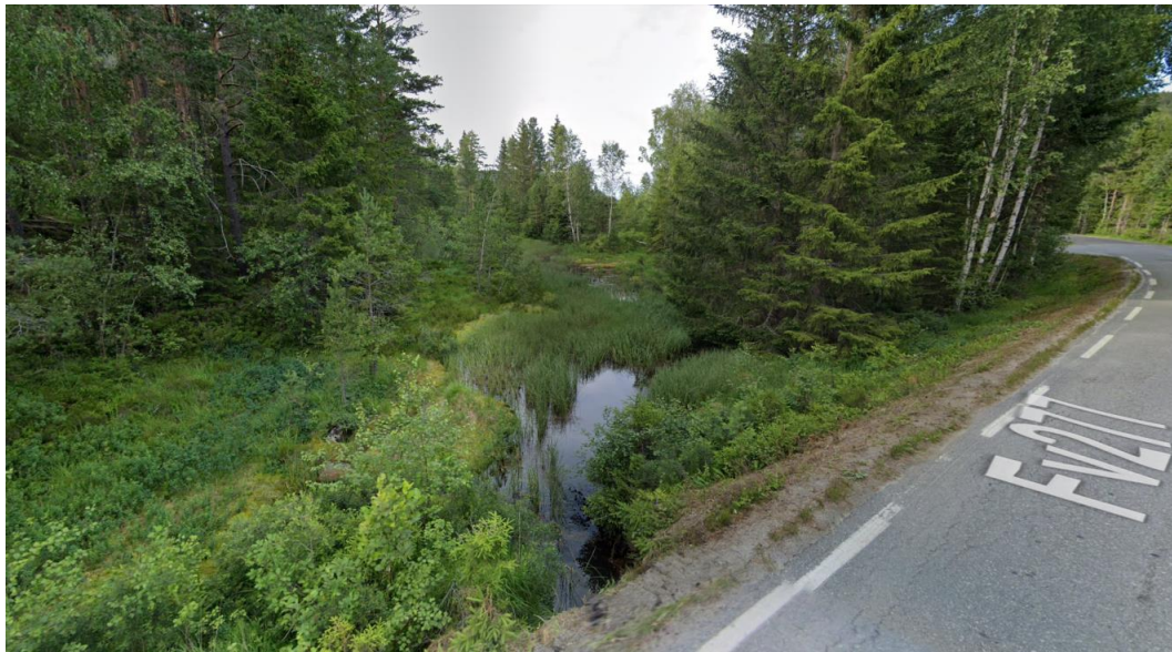
Figur 3: Bekk i planområdet munner ut i Nidelva via kulvert under fv.3714 (markert i bildet som fv.277). Kilde: Google maps
