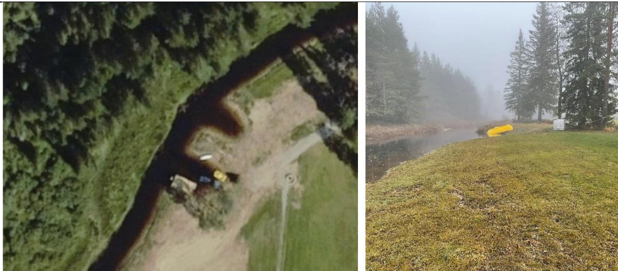
Figur 24 Område for båtopplag. Bildet til venstre er hentet fra google maps. Bilde til høyre er hentet fra Faun-rapporten.
