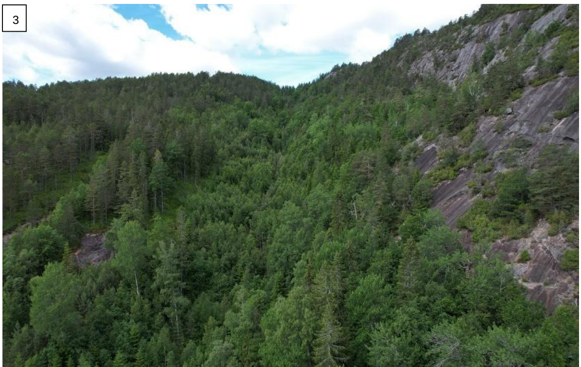
Figur 18. Oversiktsbilde over skaret mellom skråningene, omkring punkt 3 i registreringskartet. Der hvor bekken renner er det tett vegetert. Til venstre i bildet ses det også hvor tynt løsmassedekket er.
