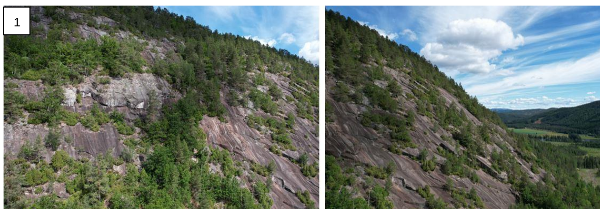
Figur 14. Overheng og bergflak i skråningen i nordvest.
