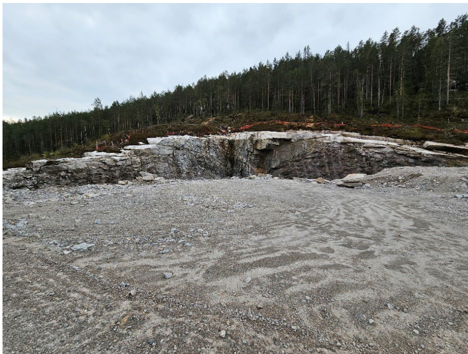
Figur 7 Bilde som viser omtrentlig høyde på fjellskjæring
