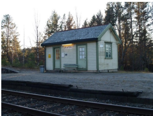
Flaten stasjon. Foto: Egil Fiane
