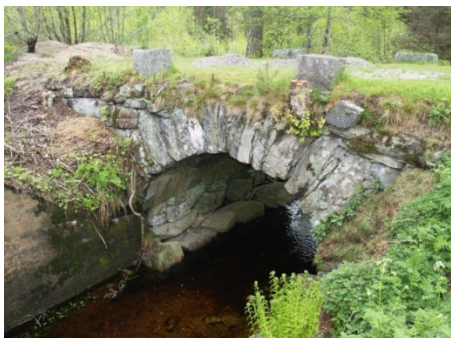
Steinbru på den gamle Telemarksvegen ved Grasåsen, Østre Mosberg. Foto: Egil Fiane
